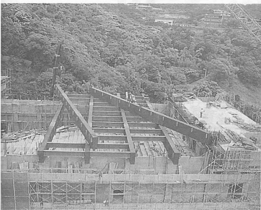
△大鋼樑迅速連成鋼架結構。
