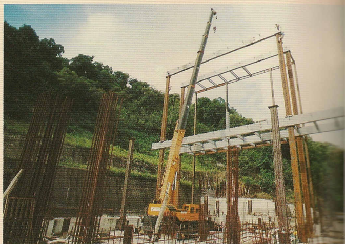
△中堂堅固之鋼骨架構工程一景。
