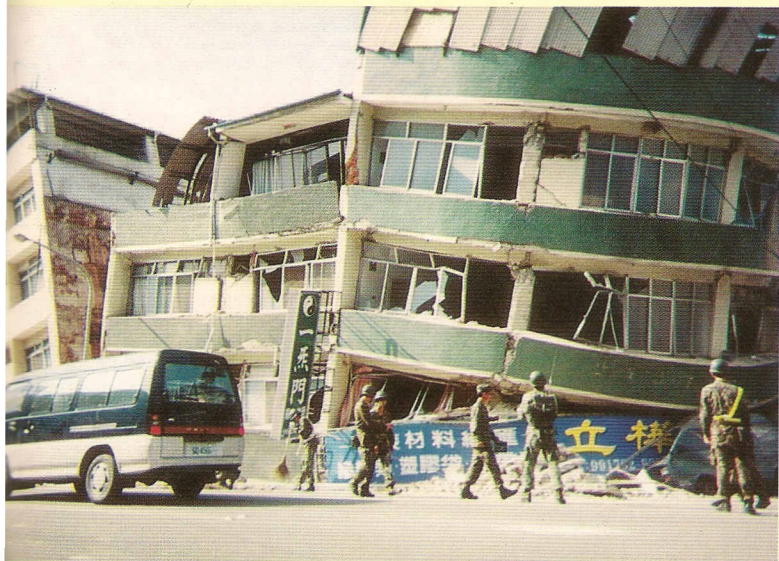
△觸目驚心！房屋倒塌情況嚴重。
