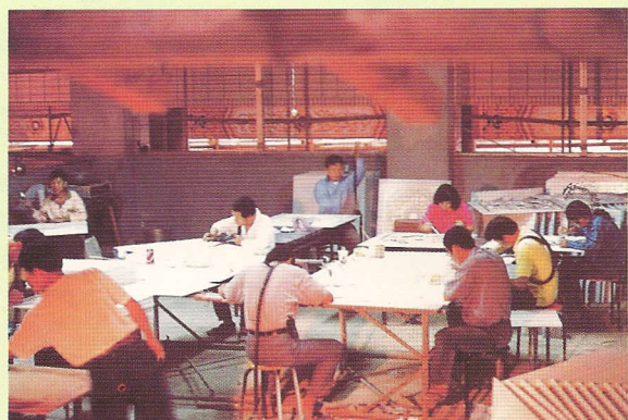
△中堂天花板之彩繪工程。
