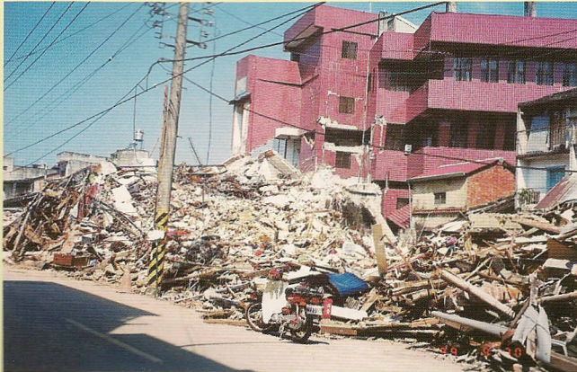
△拆除過的房子。
