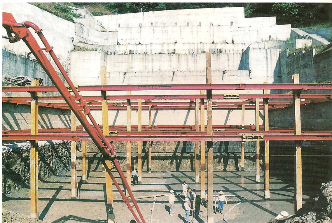
打穩地基，鋼骨上架。
