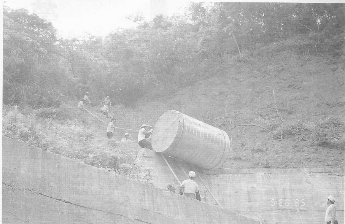
△飲水思源——安裝大型蓄水槽工程。
