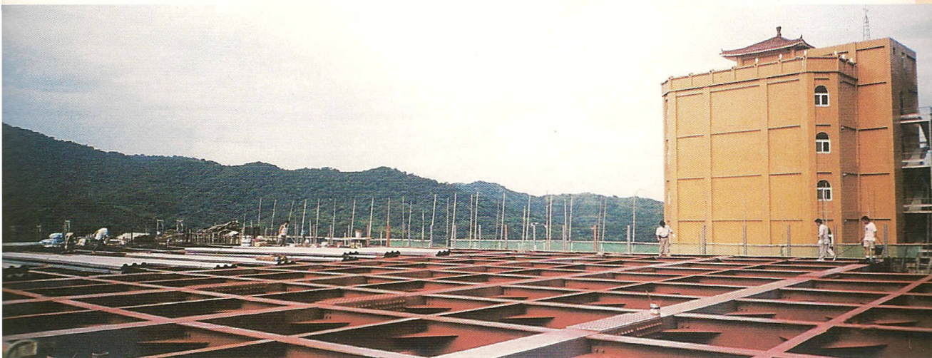
老中殿前方堅固的停車場架構。
