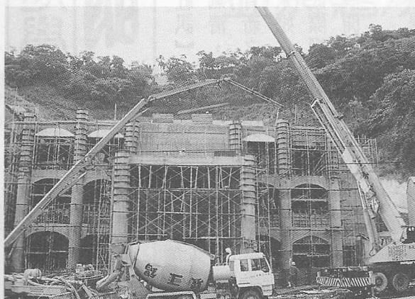
△工程已進到四樓。
