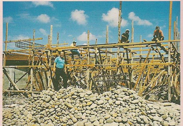
△菲國描戈律忠恕道院建築工地。
